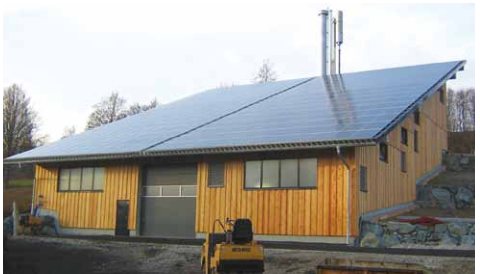
Das Heizkraftwerk Schönbrunn fügt sich in die Landschaft ein. Auf dem Dach erzeugt eine Photovoltaikanlage Strom.
